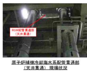
第2.3-13図 原子炉補機冷却海水系配管貫通部とRCWHx(C)/A内の
