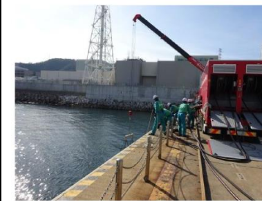
水中ポンプ設置の状況
