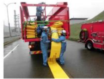
ホース設置の状況
