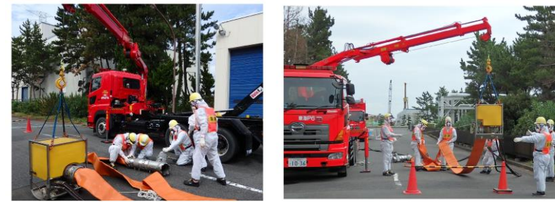
第1.0.13-3図 放射線防護具類を着用した状態での可搬型代替注水ポンプ車の設置作業
