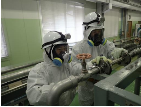
窒素ガス代替供給設備の配管へ短管取付け
