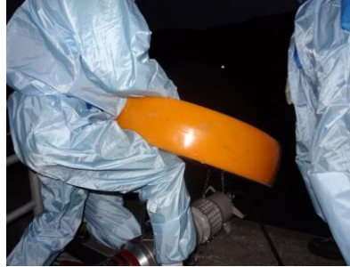
水中ポンプ設置準備（夜間）
