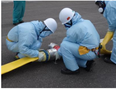
ホース接続作業（昼間）
