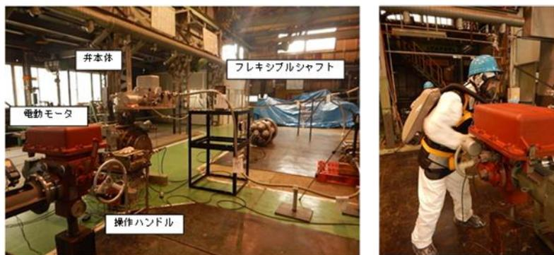
ベント操作（遠隔手動弁操作機構）
