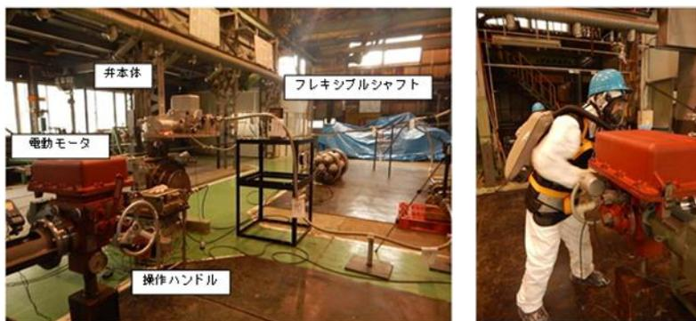
バント操作（遠隔手動弁操作機構）
