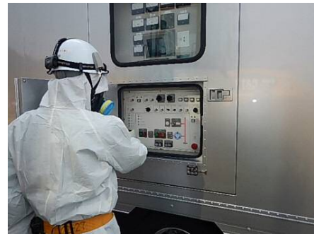
高圧発電機車での作業
