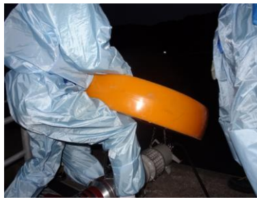
水中ポンプ設置準備（夜間）
