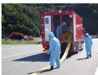
ホース展張作業（昼間）
