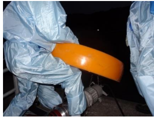
水中ポンプ設置準備（夜間）
