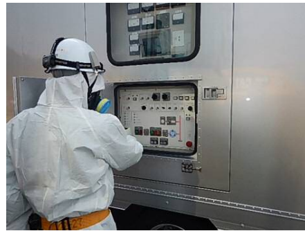
高圧発電機車での作業
