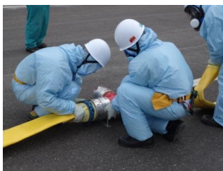
ホース接続作業（昼間）
