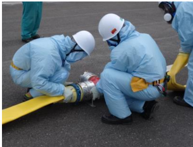
ホース接続作業（昼間）
