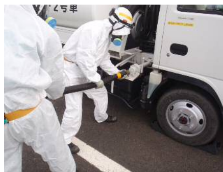
タンクローリへの燃料ホース接続
