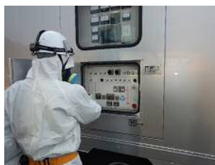
高圧発電機車での作業
