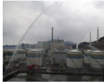
小型放水砲による放水状況
