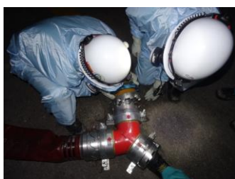
ホース接続作業（夜間）
