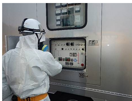
高圧発電機車での作業
