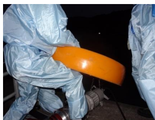
水中ポンプ設置準備（夜間）
