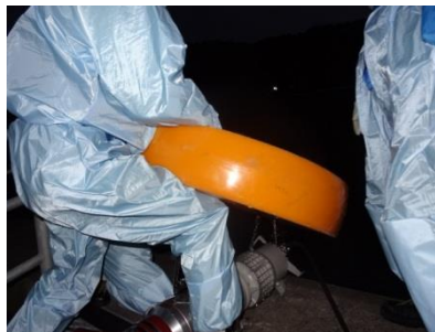
水中ポンプ設置準備（夜間）
