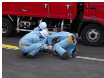
ホース接続作業（昼間）
