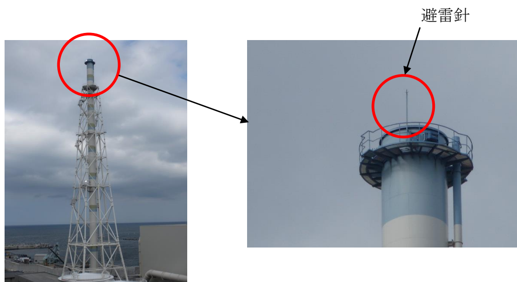
第41-1-12図 避雷設備の設置例 (排気筒)
