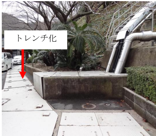
屋外消火配管のトレンチ化
