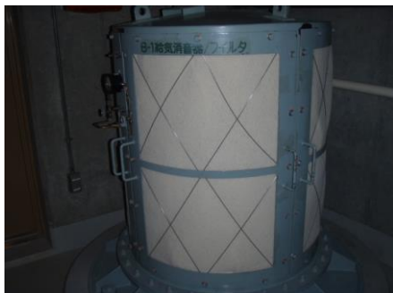
B－給気消音器フィルタ
