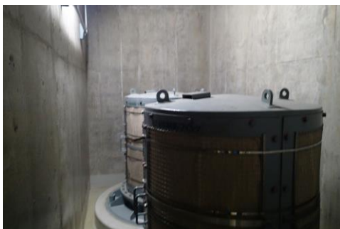
A-給気消音器フィルタ
