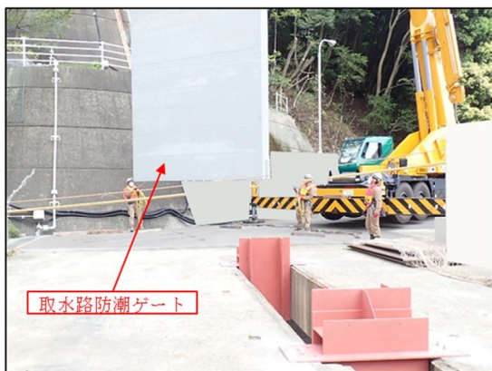
① 取水路防潮ゲートを角落し開口部に挿入した状態から吊り上げ、所定の場所へ移動。
