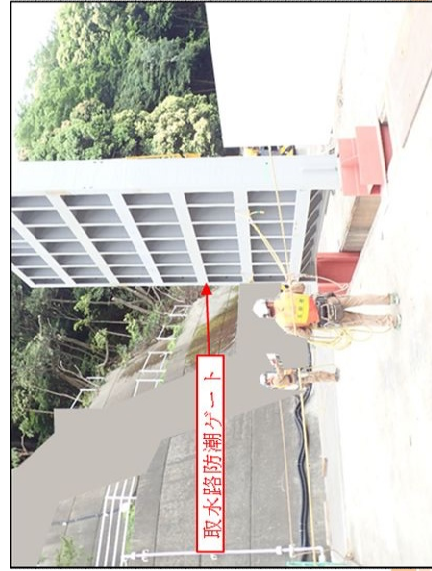
② 所定位置から地切り後、取水口角落し開口部に挿入
