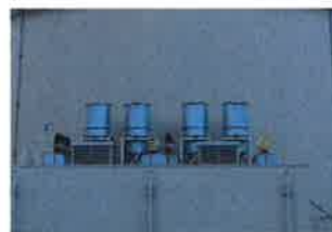
図3 主蒸気逃がし弁消音器の設置状況（左3号炉、右4号炉）
