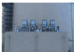
図3 主蒸気逃がし弁消音器の設置状況（左3号炉、右4号炉）
