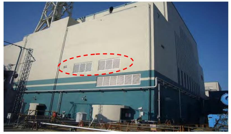
図6-2 非常用ディーゼル発電機電気品区域換気空調系（非常用ディーゼル発電機非常用送風機含む）の外気取入口
