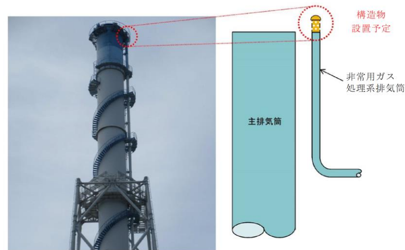
第 2 図 非常用ガス処理系排気筒 概略図
