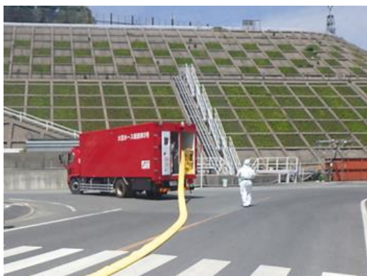
ホース敷設作業 (EL8.5m~15m 西側道路付近)
