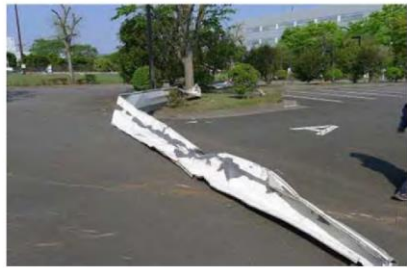
飛散した鋼板製屋根材
