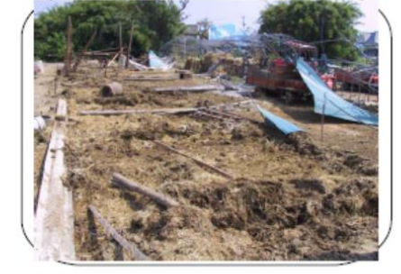
牛舎の屋根東方向、柱・トタン板は西方向に飛散している
