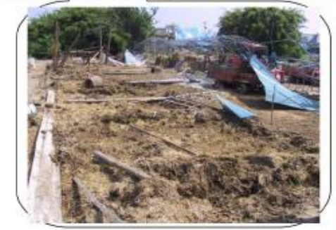
別図 1-1 平成 16 年 6 月 27 日佐賀県で発生した F 2 竜巻による屋外屋根の被害状況 (1)
