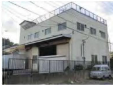
屋上フェンスの被害
