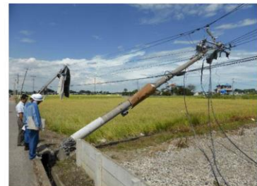
電柱の倒壊
