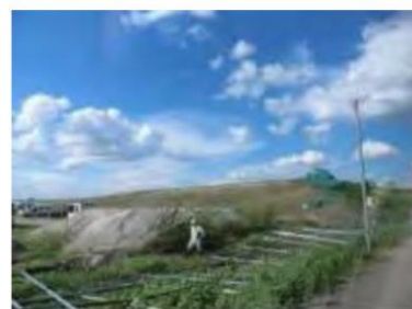
フェンスの被害
