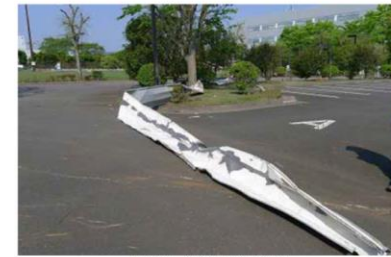
飛散した鋼板製屋根材
