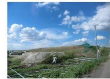
フェンスの倒壊
