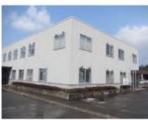
④-11 窓ガラス
