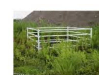
③-12 鋼製フェンス
