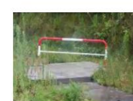
③-9 鋼製フェンス
