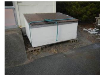
#350 鋼製ボックス
