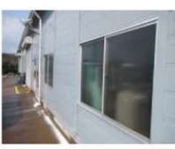
④-12 窓ガラス
