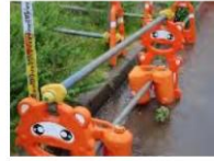
③-2 鋼製車止め (単管バリケード)
