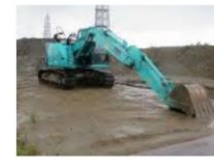
③-14 建設重機 (バックホー)
