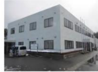
④-2 窓ガラス
