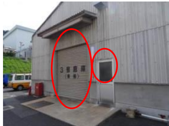
58 3号倉庫東側シャッター, ガラス窓
