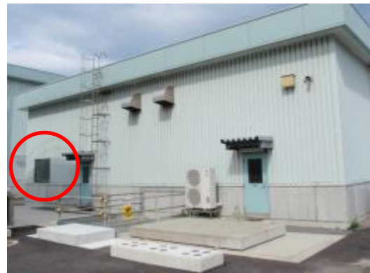
140 給水設備建物西側ガラス窓
