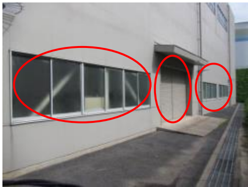
20 補機メンテナンス建物西側シャッター，ガラス窓
