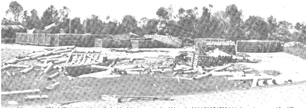
図 28 Grand Gulf 原子力発電所資材置き場におけるパイプの散乱状況
