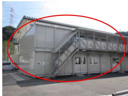
37 日立5号棟ガラス窓（4.4m盤）
