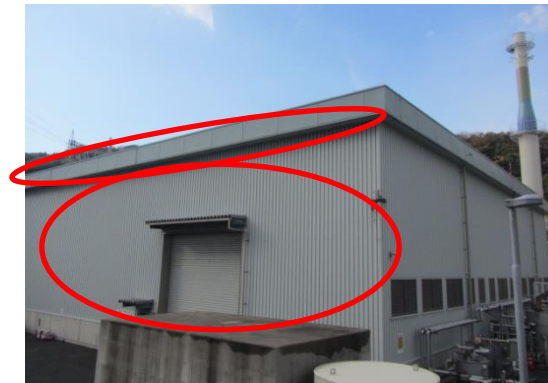
165 3号炉補助ボイラ
