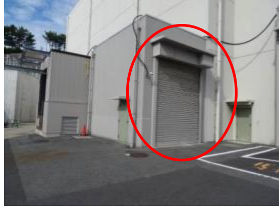
66 サイトパンカ建物南側シャッター
