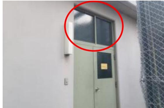
97 2号開閉所ガラス窓
