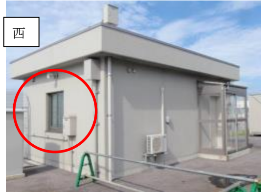
148 北口建物西側ガラス窓
