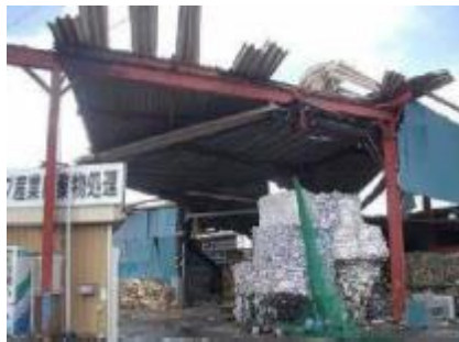
折板の損傷
