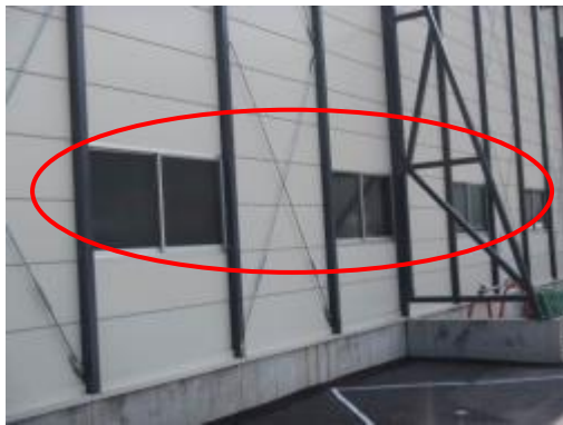
36 日立6号棟ガラス窓（4.4m盤）
