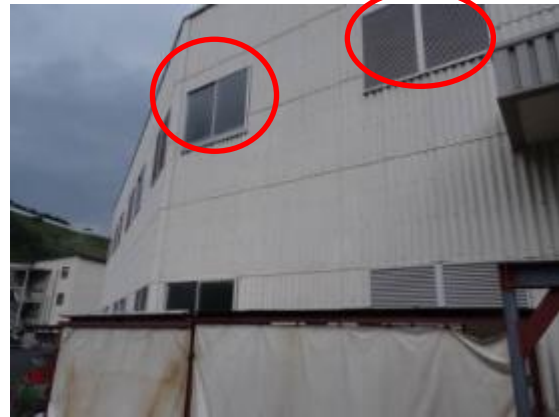
89 5号倉庫給気用格子，ガラス窓
