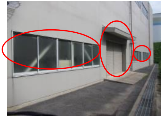
16 補機メンテナンス建物西側シャッター，ガラス窓
