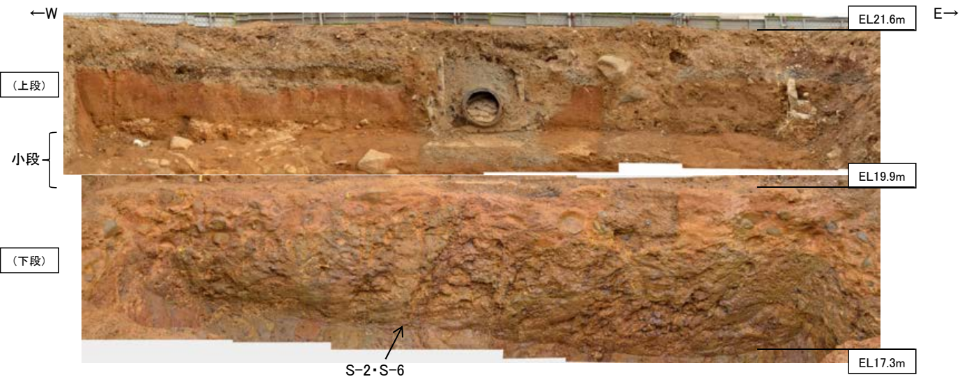
写真(No2トレンチ 北面)
