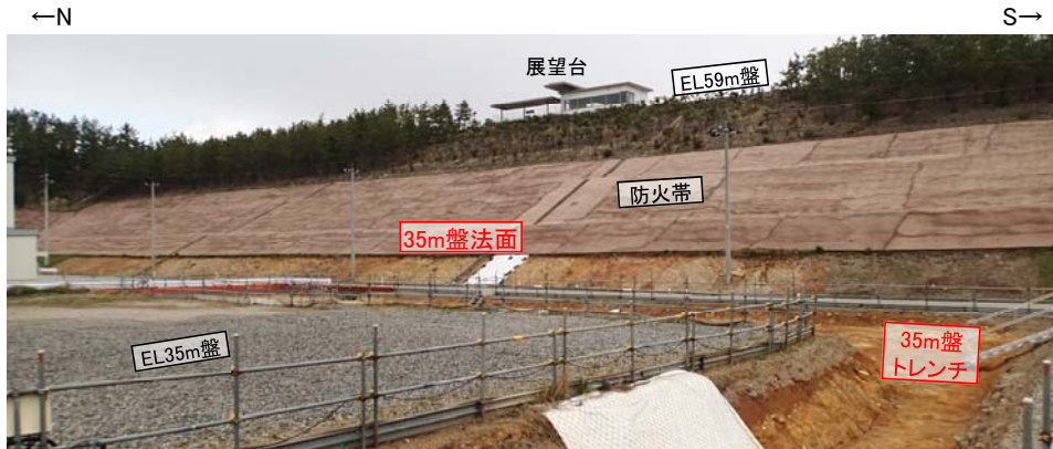
35m盤法面及び35m盤トレンチ 全景写真
