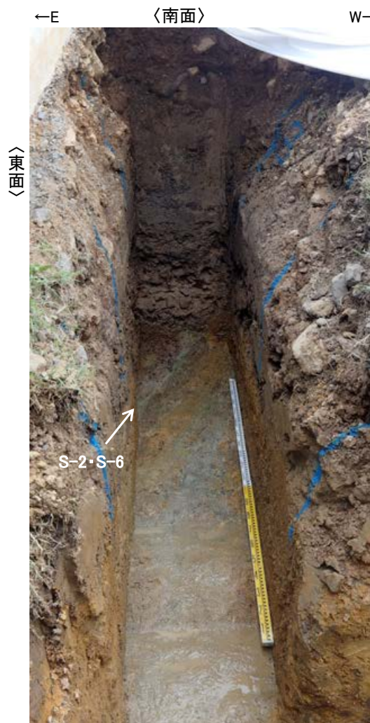
写真(事務本館前トレンチ)
