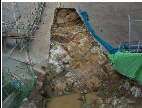
防波壁東端部 岩盤露出状況
