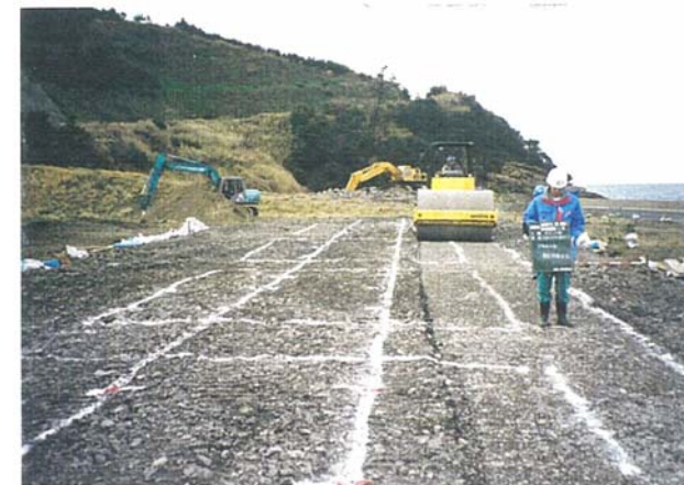
振動ローラによる転圧状況
