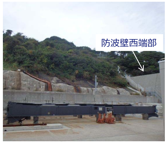
防波壁西端部 状況写真
