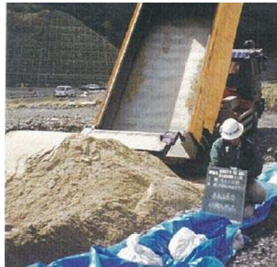
埋戻土(購入土) 現地写真(H11年)
