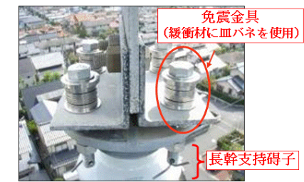
第 2.2.4-10 図 免震対策の施工状況
