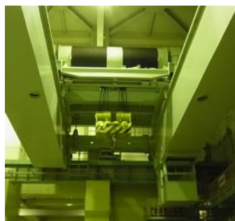
原子炉建物天井クレーン外観
