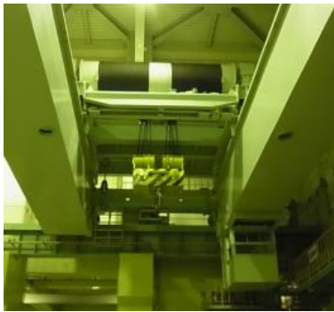
原子炉建物天井クレーン外観
