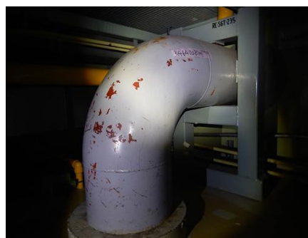
配管補修箇所（可搬型照明使用）
