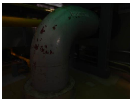
配管補修箇所（可搬型照明なし）
