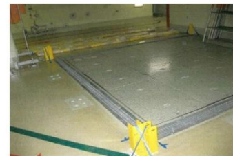
支柱レールの取付状況
