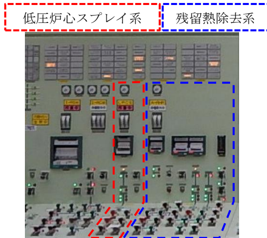
第 2.4.1 - 4 図 系統区分による配置例
