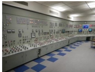
非常用照明点灯時
