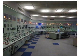
直流非常灯点灯時
