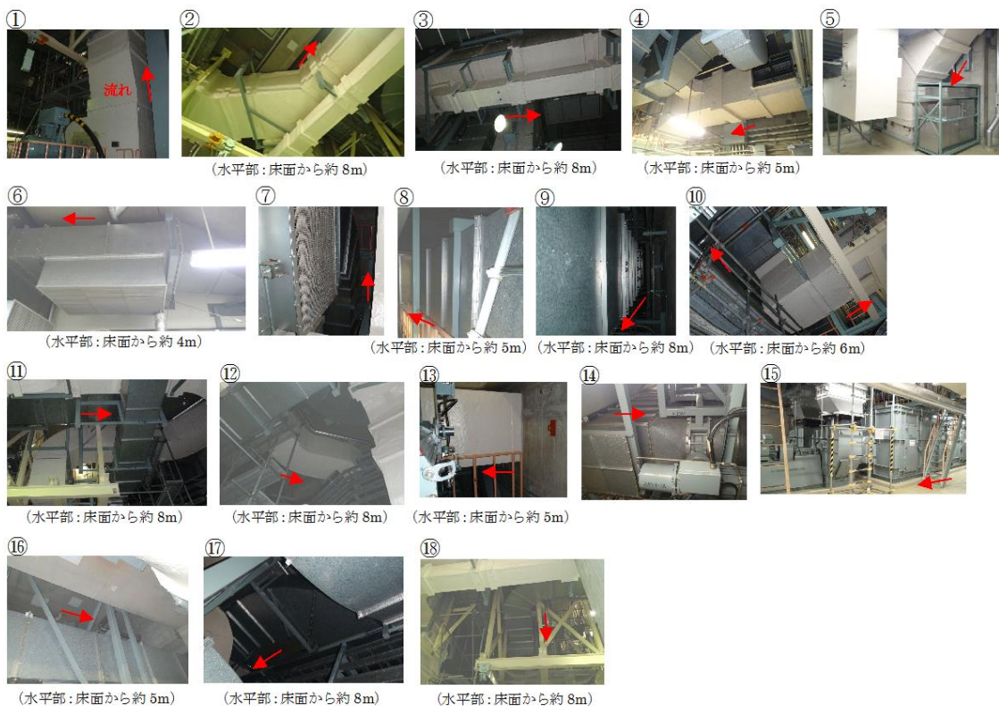
別紙図 1-9-2-2 ダクト敷設状況
