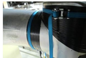
第3図 修復模擬作業状況
