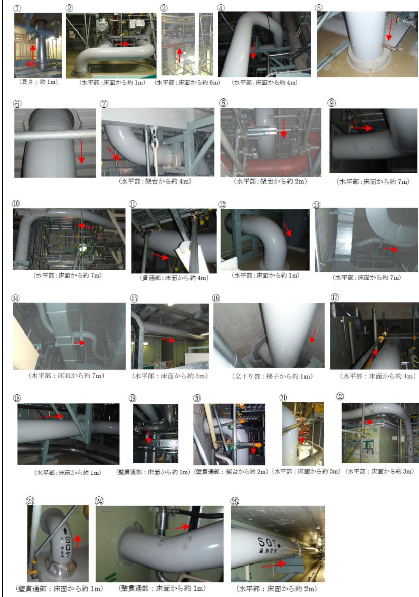
別紙図 1-9-1-2 配管敷設状況
