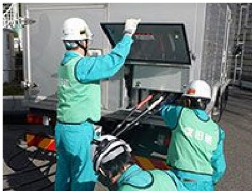
高圧発電機車を用いた電源供給訓練
