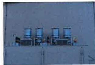
図3 主蒸気逃がし弁消音器の設置状況 (左3号炉、右4号炉)
