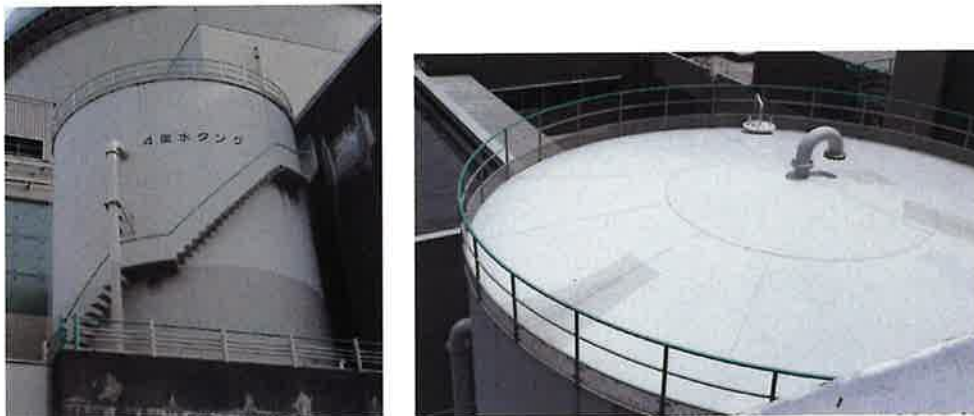
図3 復水タンク外観写真（左 側面部、右 屋根部）
