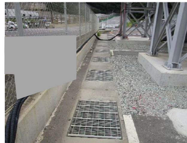
構内排水路写真(例示)
