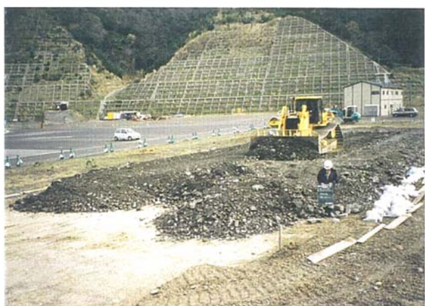
巻き出し整地状況
