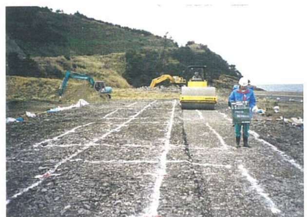
振動ローラによる転圧状況
