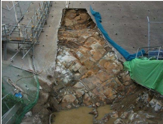
防波壁東端部 岩盤露出状況
