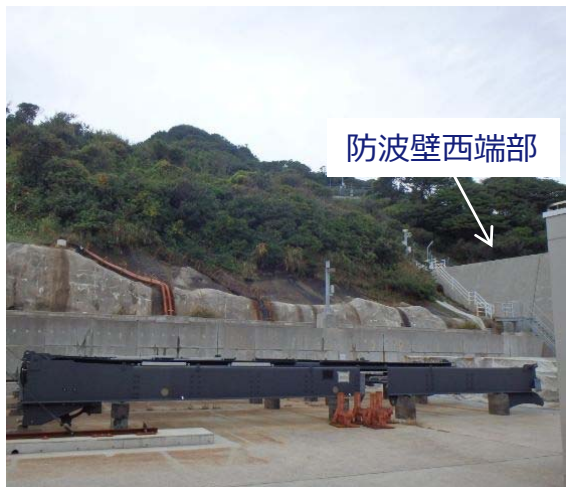
防波壁西端部 状況写真
