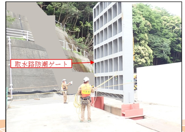
② 所定位置から地切り後、取水口角落し開口部に挿入
