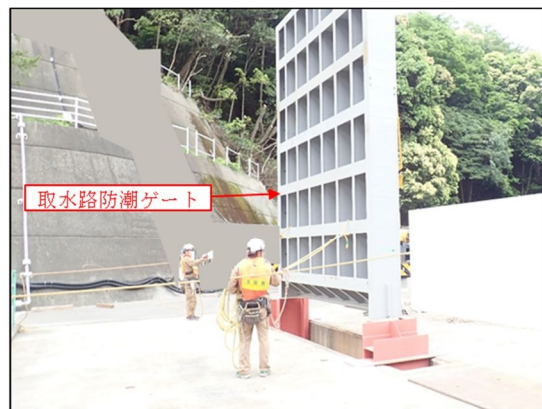
② 所定位置から地切り後、取水路角落し開口部に挿入
