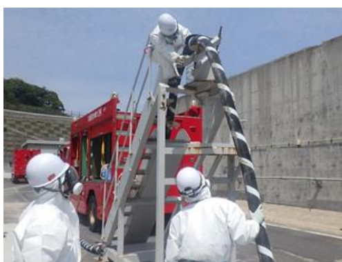
防水壁ホース乗り越え作業 (模擬) (EL8.5m 2号炉取水槽付近)
