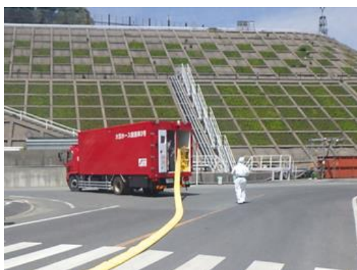
ホース敷設作業 (EL8.5m~15m 西側道路付近)
