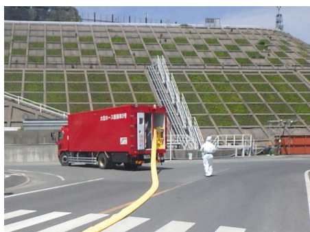
ホース敷設作業 (EL8.5m～15m 西側道路付近)
