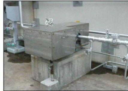
図 5-2 燃料移送ポンプ外形写真
