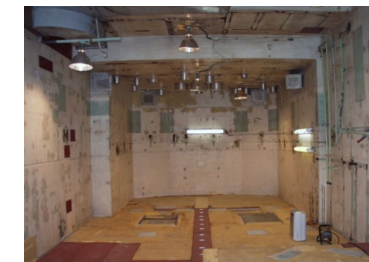
機器撤去後の重水ポンプ室
