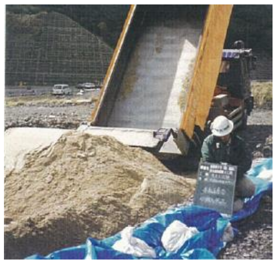
埋戻土(購入土) 現地写真(H11年)
