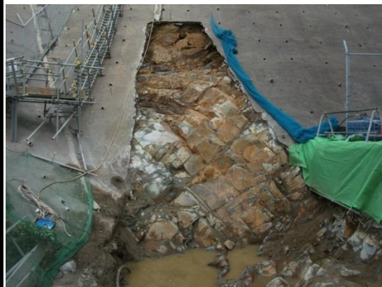
防波壁東端部 岩盤露出状況
