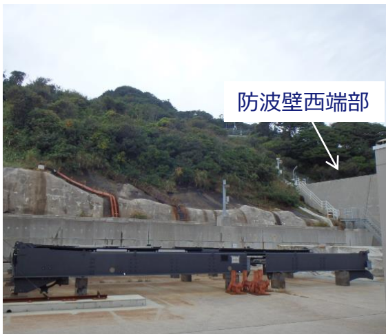
防波壁西端部 状況写真
