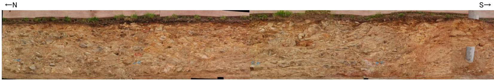
写真(35m盤法面)
