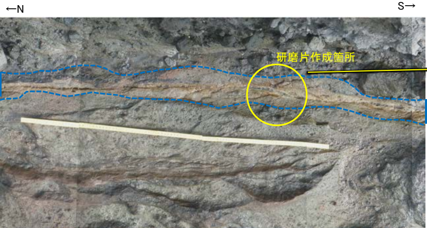
固結した破碎部 K-3露頭 a地点 破碎部の状況写真
