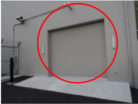
92 44m版事務所東側シャッター
