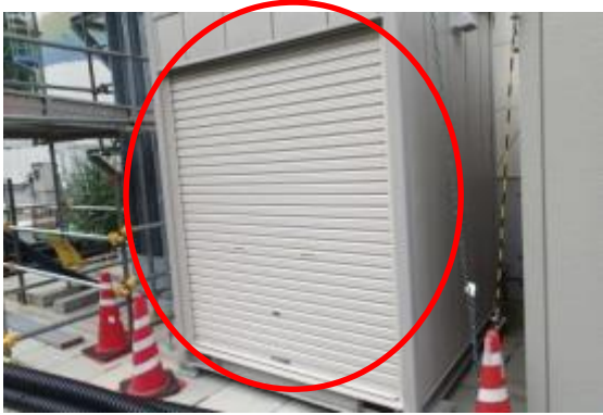
105 資材倉庫シャッター
