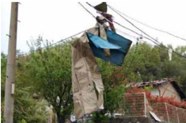
電線等に引っ掛かった飛来物（鋼板製屋根材）
