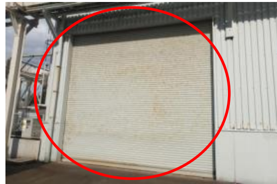
95 1号開閉所西側シャッター
