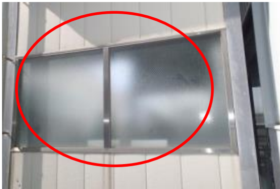
94 1号開閉所ガラス窓
