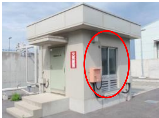
143 重油タンク移送ポンプ室南側ガラス窓
