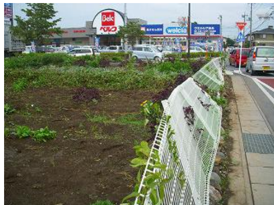
写真31 フェンスの変形
