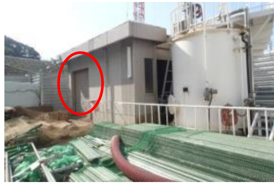
99 鉄イオン貯蔵建物南側シャッター
