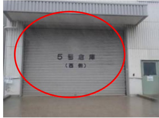
91 5号倉庫西側シャッター
