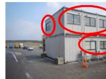
③-1 窓ガラス
