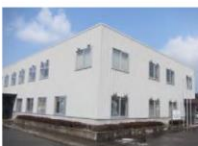
④-11 窓ガラス
