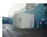
①-20 扉, 換気フード, 猿梯子
