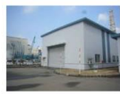
①-16 屋根, シャッター
