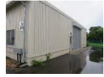
⑤-13 屋根, シャッター
