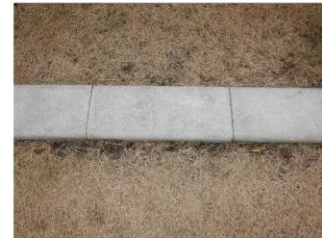
#81 コンクリート製蓋
