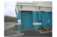
①-23 シャッター, 配管
