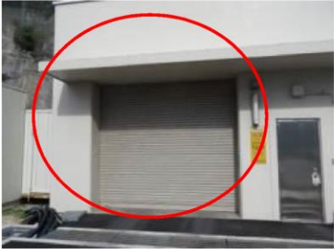
73 固体廃棄物貯蔵庫A棟西側シャッター
