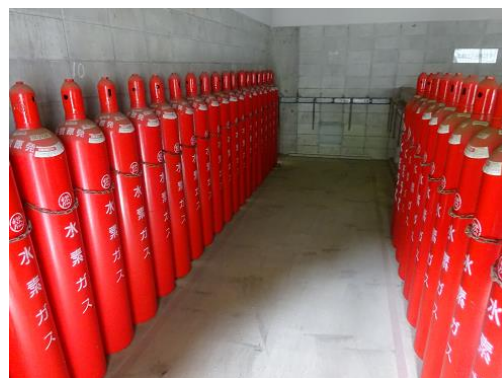
水素ガスボンベの固縛状況 (高圧ガス貯蔵所)
