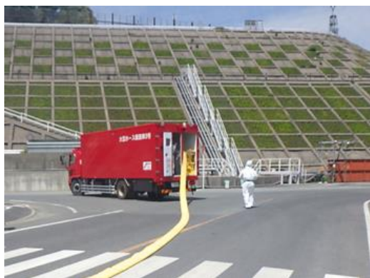
ホース敷設作業 (EL8.5m~15m 西側道路付近)
