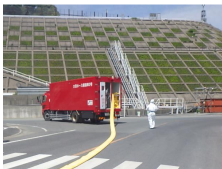
ホース敷設作業 (EL8.5m～15m 西側道路付近)
