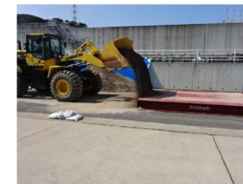
第6図 段差復旧状況
