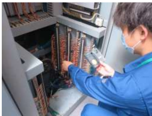
仮設計器による温度確認の一例
