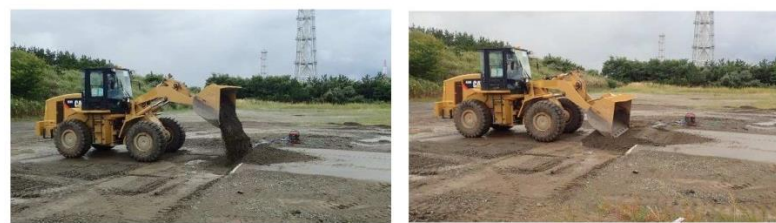
段差復旧状況①
