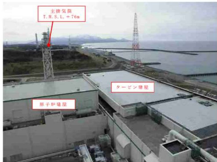
第4.3-2図 津波監視カメラ設置位置
