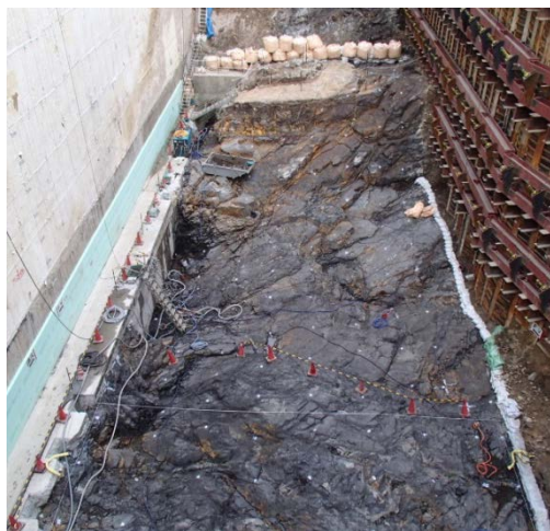
掘削面 (T. P. -5.0m)
