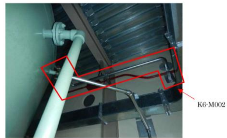
第1-2図 現場状況写真 (燃料ディタンク周辺)
