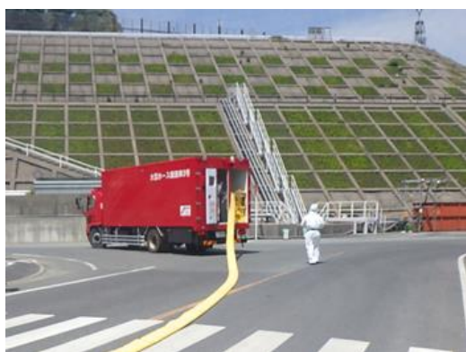
ホース敷設作業 (EL8.5m~15m 西側道路付近)
